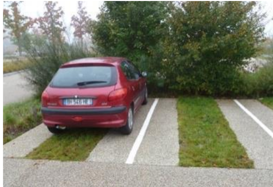
Bandes enherbées et stationnement avec système alvéolaire
