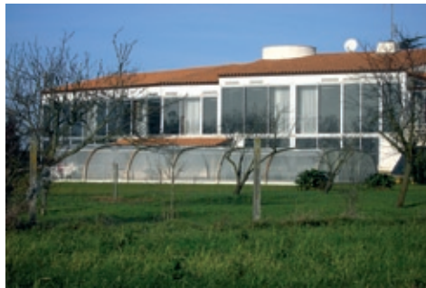
Serre climatique en façade sud, Bourcefranc
