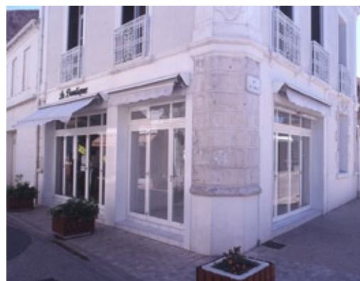
Vitrines d'angle logées dans les ouvertures existantes, Saint-Trojan
