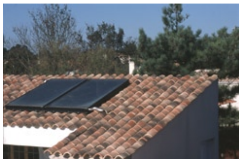
Capteurs solaires intégrés sur toiture neuve, Chéray
