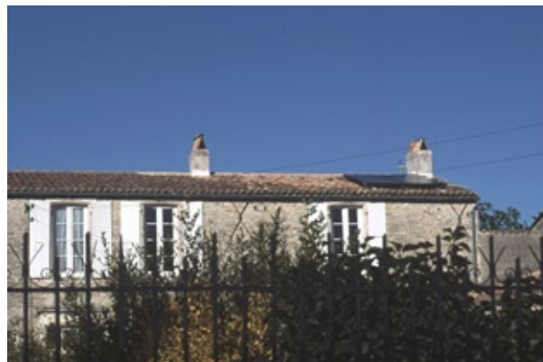
Capteurs solaires sur toiture ancienne
