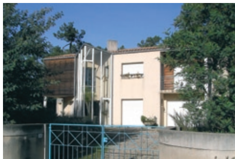
Serre solaire, Saint-Trojan
