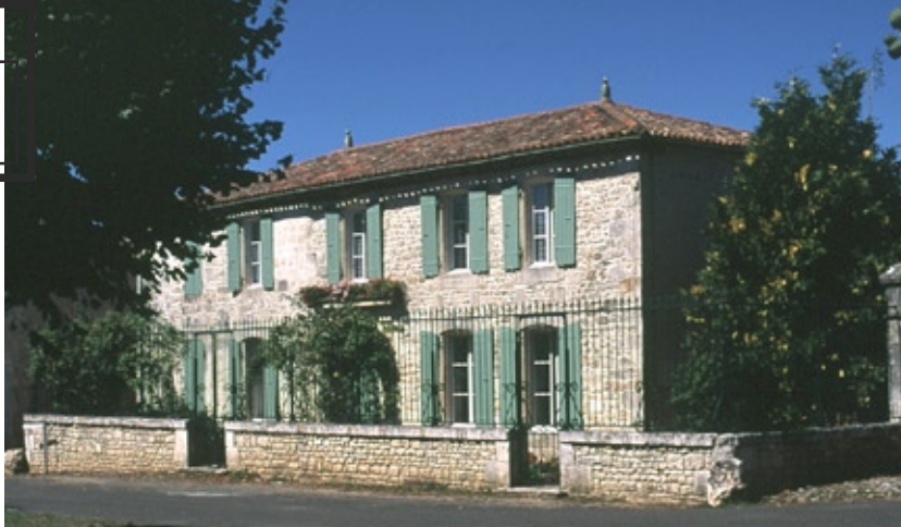
Sur une maison saintongaise, le piquage de l'enduit de façade est un non-sens technique autant qu'esthétique, Saint-Sornin.
