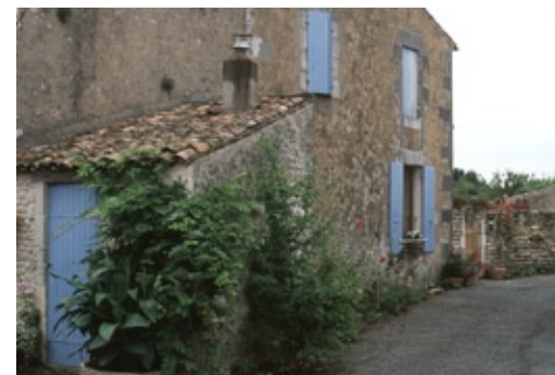
Habitation enduite, murs et dépendances en moellons apparents, Souhe, Le Gua
