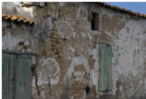
La vêtue traditionnelle : moellons tout venant, enduit à la chaux de couleur du sable et badigeon au lait de chaux, Souhe, Le Gua
