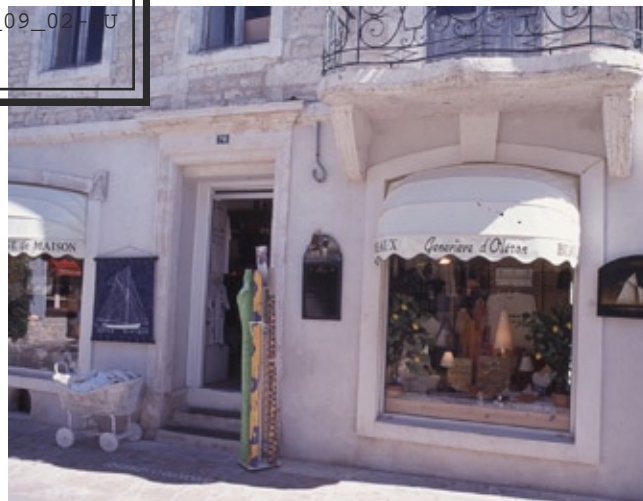
Les vitrines ont conservé les modénatures de la façade d'origine, Saint-Trojan
