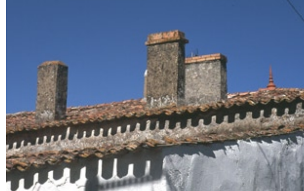
Tuiles canal, rives saintongeaises, souches maçonnées, mitres en briques et épis de faîtage, Saint-Sornin
