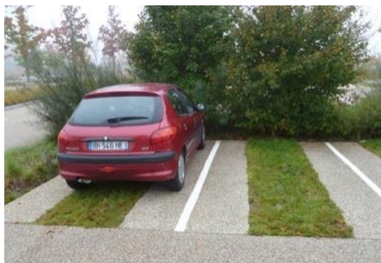
Bandes enherbées et stationnement avec système alvéolaire
