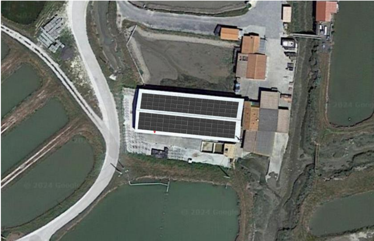
Installation de 206 capteurs photovoltaïques en surimposition de toiture
